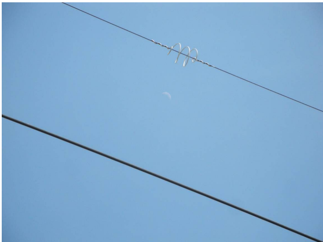
Figura 37. L'utilizzo di una spirale anticollisione su linee aeree AT all'interno dell'oasi WWF di Focognano. La spirale è posta sul filo di guardia [Foto: C. Scoccianti]
