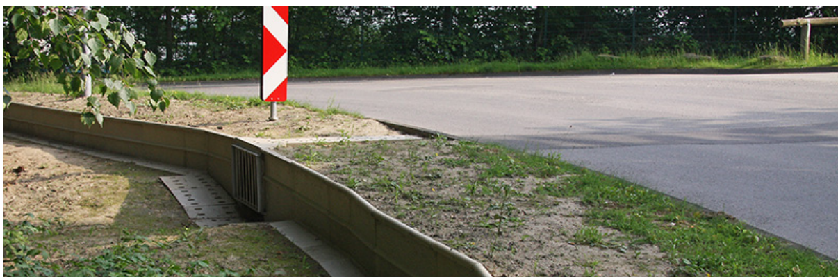
Figura 35. Esempio dell'utilizzo delle barriere anti-attraversamento per la fauna minore (Fonte: www.aco.it )
