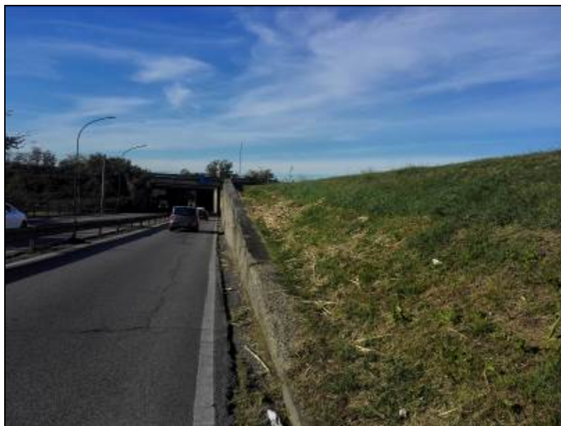
Figura 3-6 Vista del muro di sostegno e del rilevato arginale esistente in adiacenza a via del Cantone
