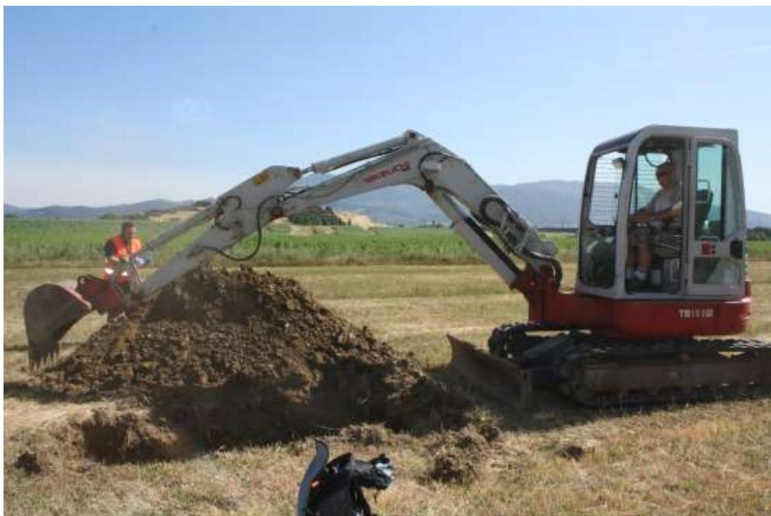
**Figura 10 - Pozzetti geognostici in corso d'opera**
